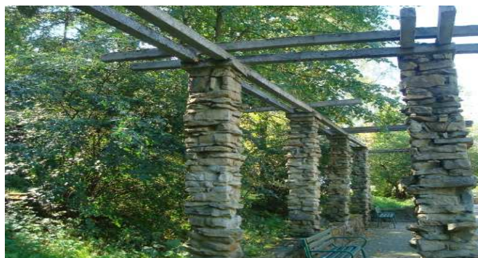
Fot.32. Żelbetowe belki pergoli przy starej pijalni wód w Krynicy-Zdrój [fot. autor]
