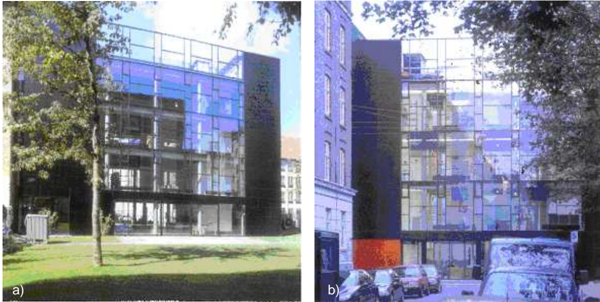
Fot.7. Dannbrogsgade Kindergarden Kopenhaga, 2000 [25], str.16
