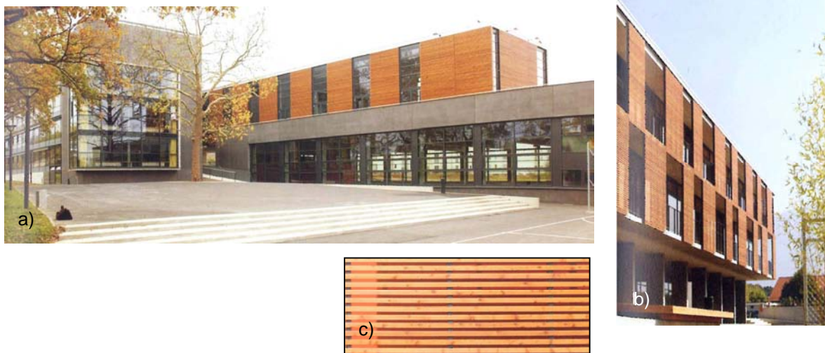
Fot.14. Tambourine School and Kindergarten, 2004 [25], str.695 a) dziedziniec szkolny, b) elewacja strefy wejścia, c) detal elewacji
